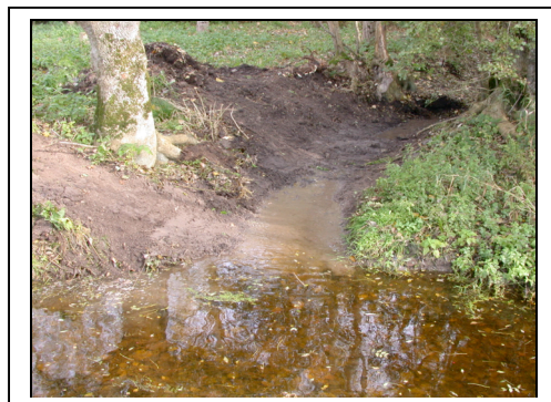
Curages visant à augmenter les connexions hydrauliques
