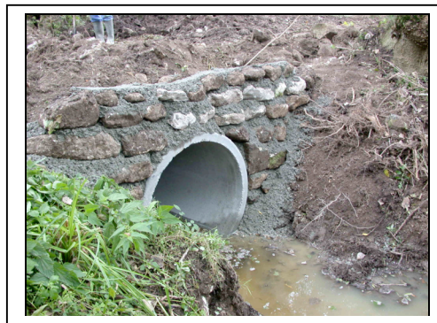
Passage busé (diamètre 800 mm)
