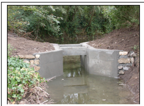
Ouvrage de gestion des niveaux d'eau
