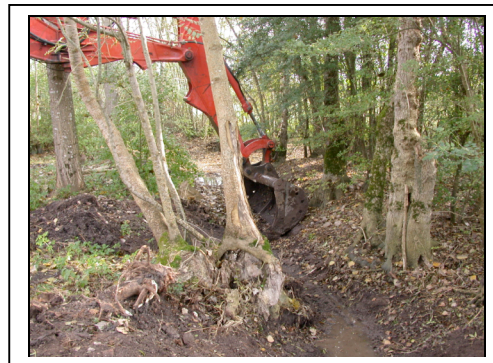
Curages visant à augmenter les connexions hydrauliques
